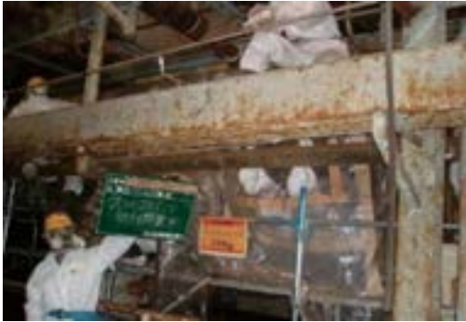
図4.8.9 特殊グローブバッグ取付作業中
