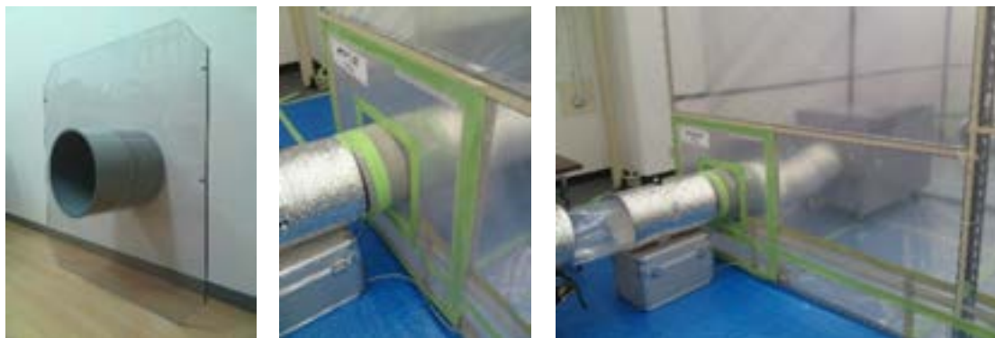
参考図 4.14 排気ダクト貫通パネル例
