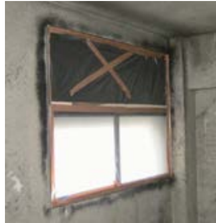
参考図 3.7 窓、換気口の隔離例
