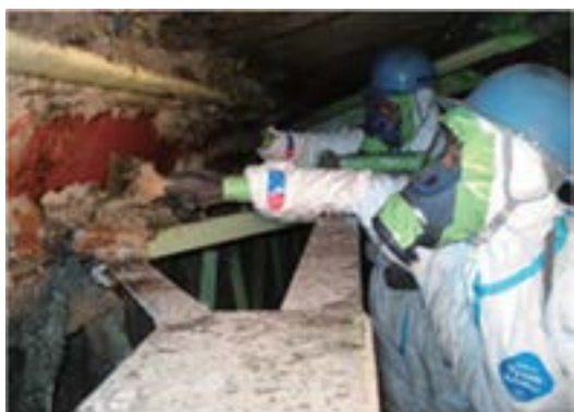
参考図3.43 手工具（ヘラ）を使用した石綿含有吹付け材の除去作業（ブラッシング）
