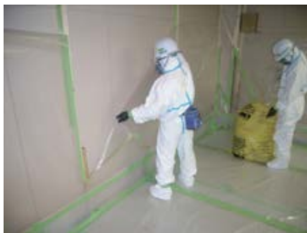
参考図3.63 隔離シートの撤去
