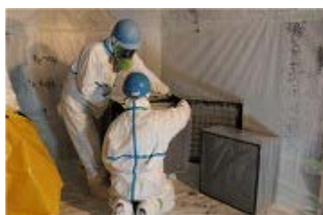
参考図 3.57 HEPA フィルタの交換
