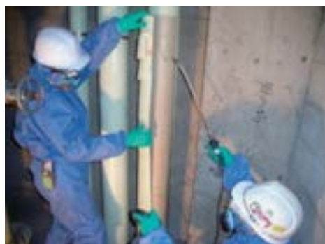
図4.7.3 保温材の取外し
