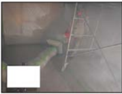
参考図 4.8 スモークマシンを使用した空気の流れの確認（集じん・排気装置設置時）
