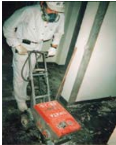
図 4.10.3 石綿含有ビニルタイルの除去例
