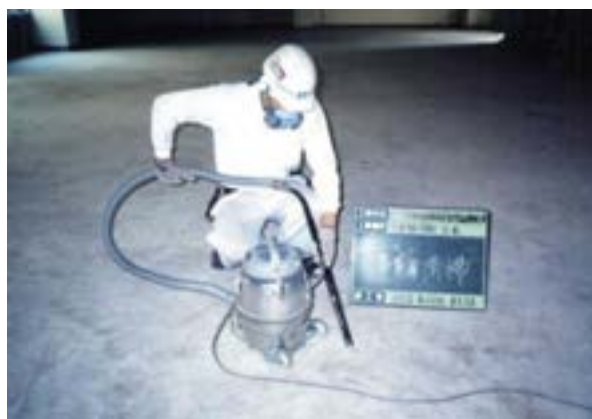
図4.10.11 清掃 高性能真空掃除機使用例
