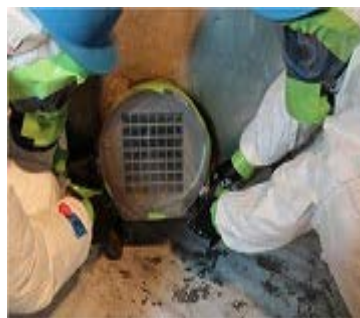
集じん・排気装置の排気口をビニールシート等で封鎖
