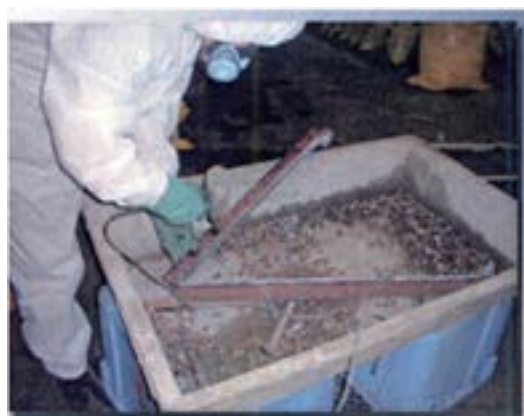
図4.10.7 掻き落とし除去作業の例
