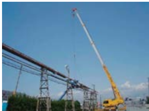
図4.8.6 配管吊り下ろし
