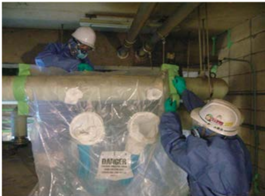
図4.8.2 グローブバッグの例
