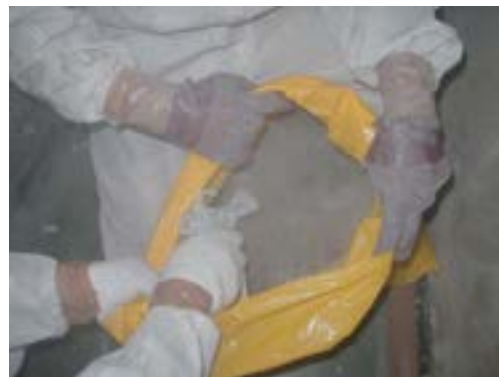
参考図3.48 袋詰めした石綿廃棄物への粉じん飛散防止処理剤を散布
