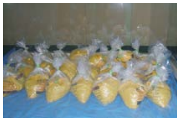
参考図3.50 除去した石綿廃棄物の一時保管
