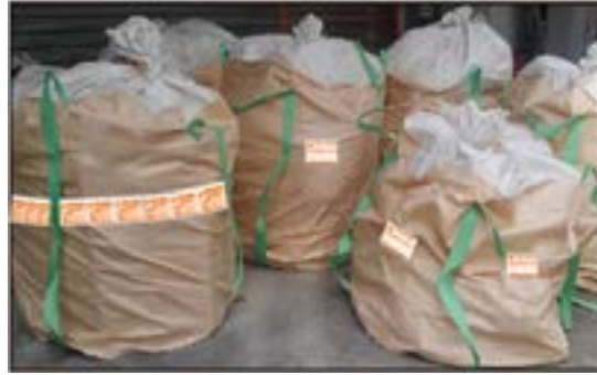
図4.10.12 石綿含有成形板廃棄物の保管例
