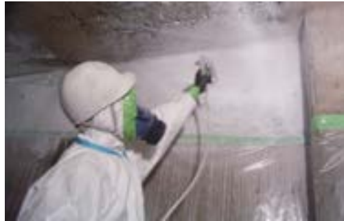
図 3.45 除去した後の下地面への粉じん飛散防止剤の散布
