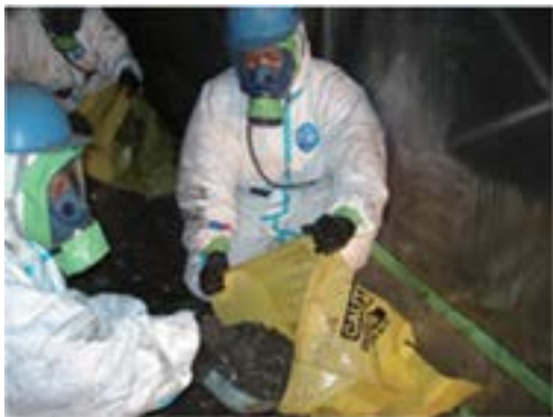
参考図3.47 除去した石綿廃棄物の袋詰め（一重目）
