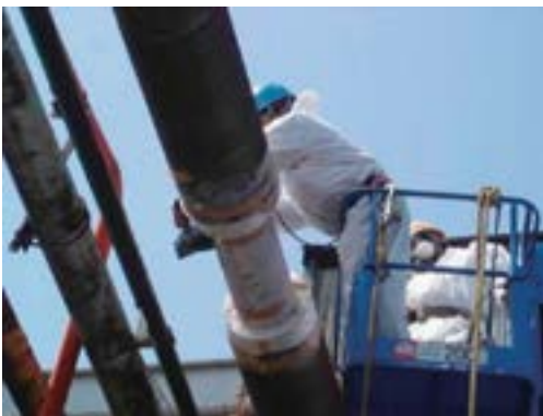
図4.8.5 切断箇所の除去と養生
