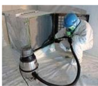
参考図 3.55 HEPA フィルタ等の清掃
