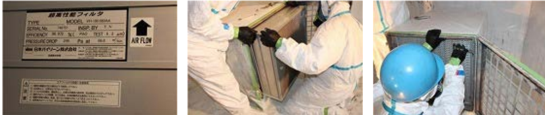
参考図 3.58 フィルタの取り付け
