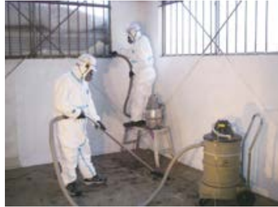
参考図3.64 高性能真空掃除機を用いた作業場内の仕上げ清掃
