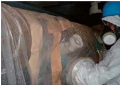
図4.8.11 石綿除去作業中2
