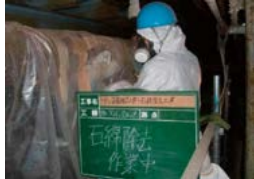
図4.8.10 石綿除去作業中1
