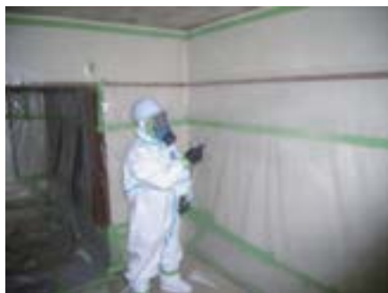
参考図3.51 隔離シートへの粉じん飛散防止
