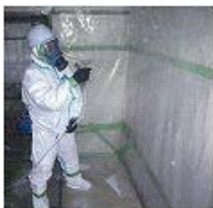
②隔離シートへの散布
