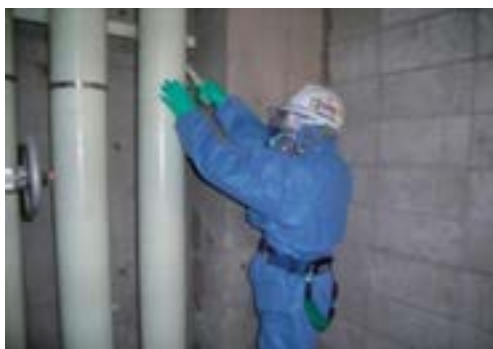
図4.7.2 保温材被覆撤去
