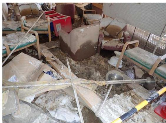
床に落下したロックウール吸音天井板
