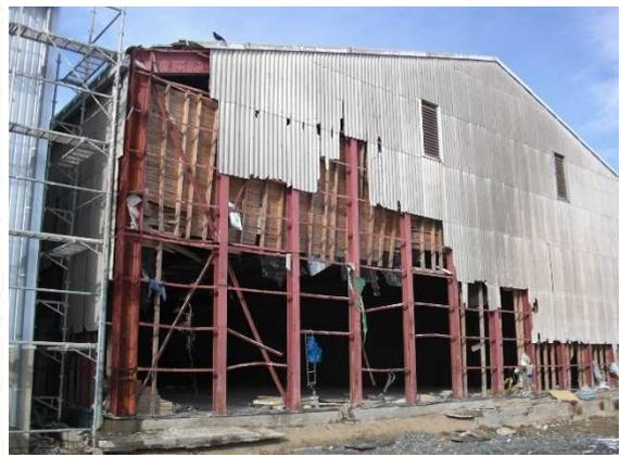
津波により破損、落下したスレート波板
