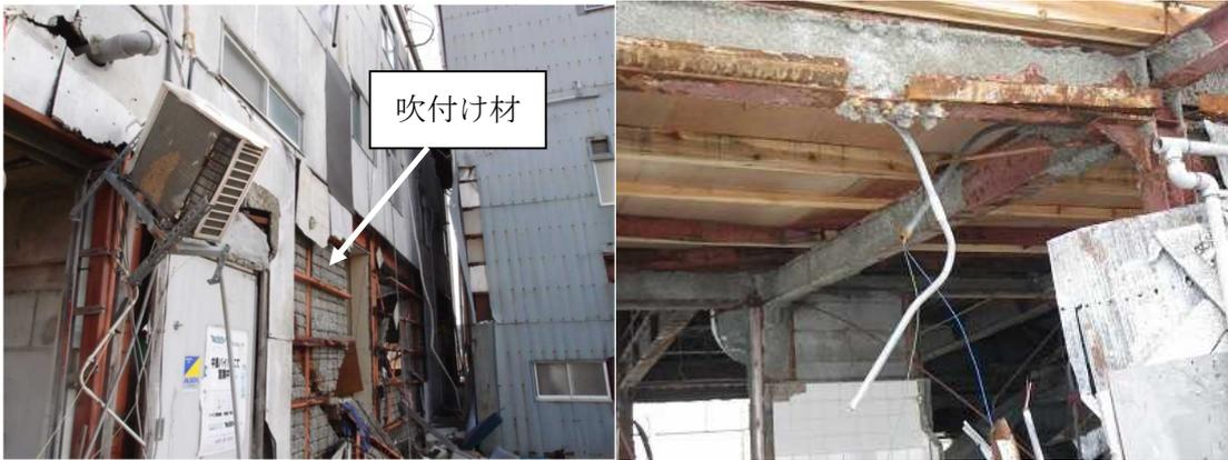
吹付け材が露出している例
