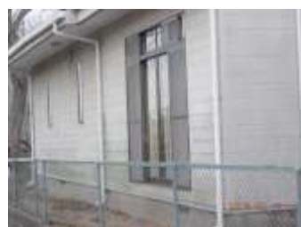
石綿含有窯業系サイディング
