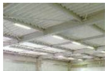
屋根用折板石綿断熱材
