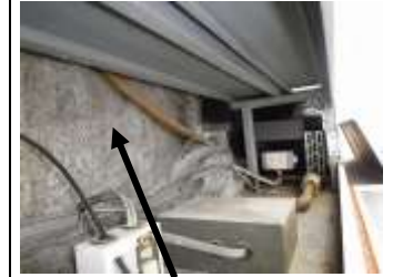
カーテンウォールの裏側
