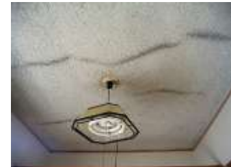
RC構造集合住宅の天井
