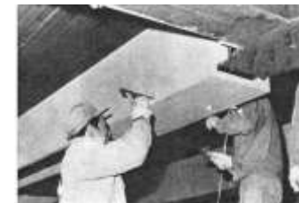
ケイ酸カルシウム板二種施工状況
