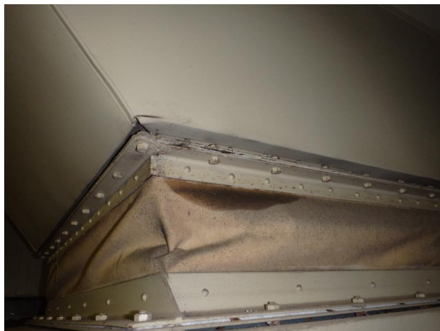
ダクト用ガスケットと継手（石綿布）
