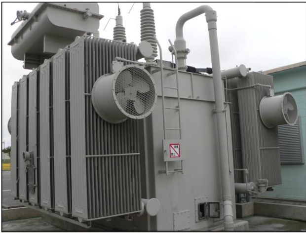
図 2.50 防音材（変電）
