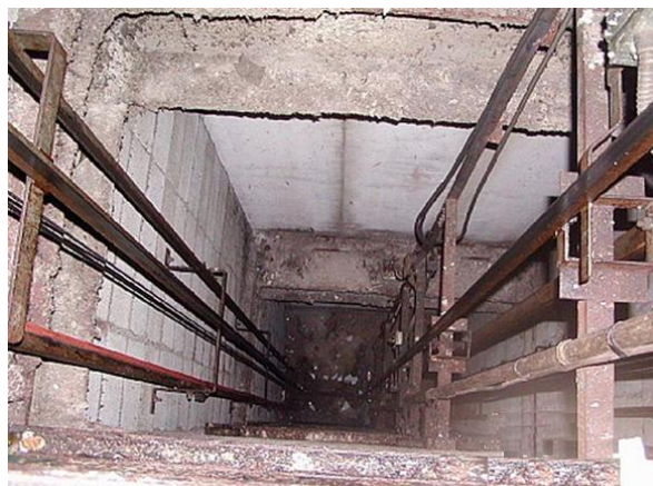
エレベーターシャフト
