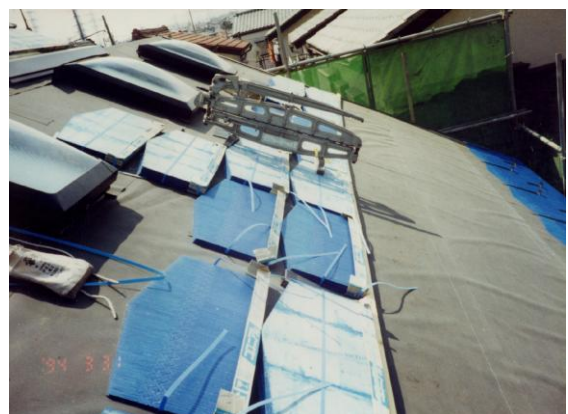
図 2.35 石綿含有ルーフィングの施工例
