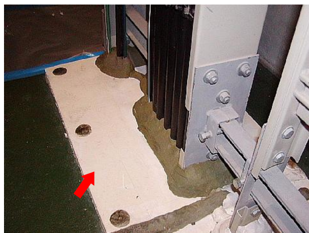
図 2.17 壁や床のケーブル貫通部の処理（けい酸カルシウム板第2種）
