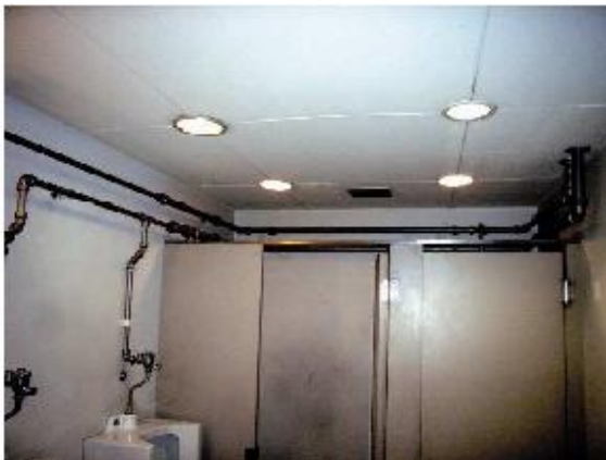
天井のフレキシブル板
