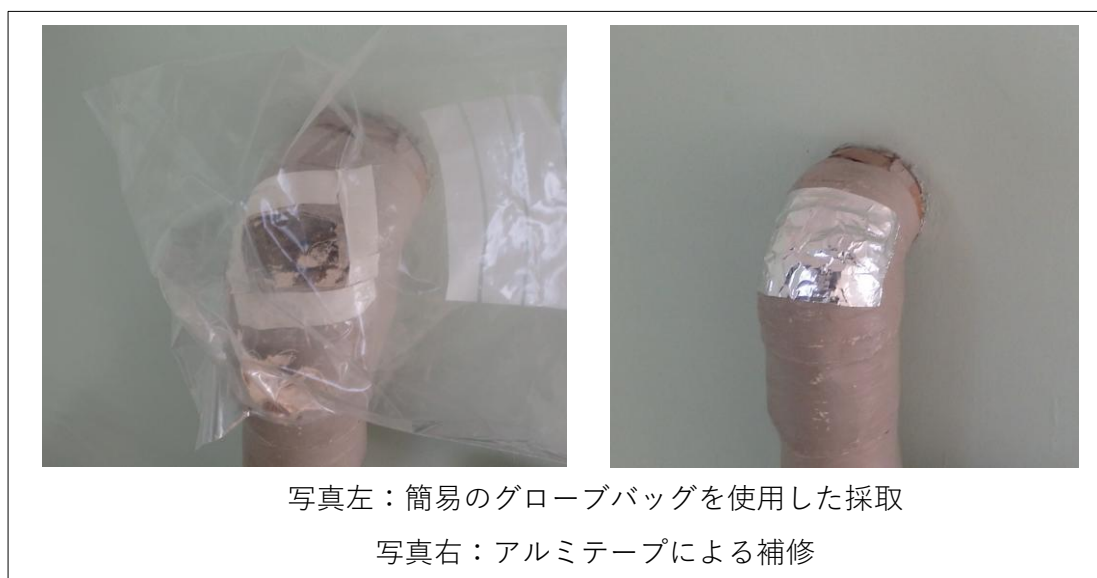
図3.22 配管保温材の採取
