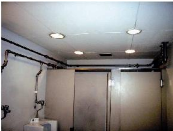
天井のフレキシブル板
