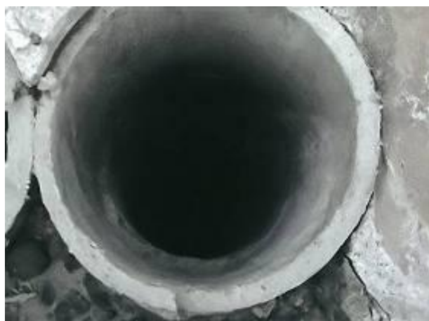
石綿セメント円筒（左写真の屋上）
