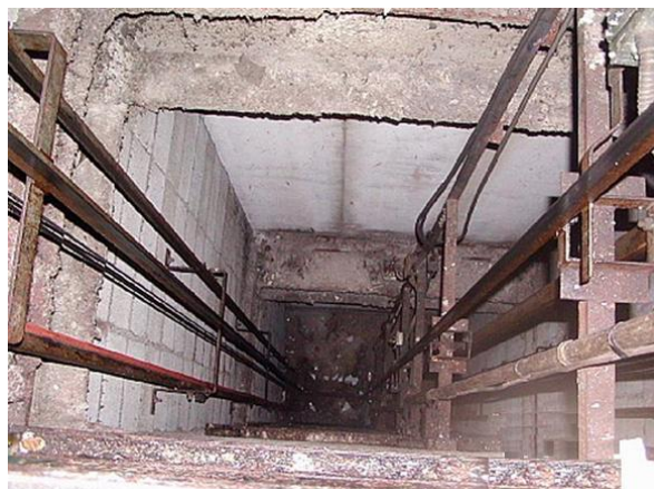
エレベーターシャフト
