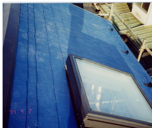
低層ビル屋上の階段室屋根の化粧スレート（アスベストコロニアル）
