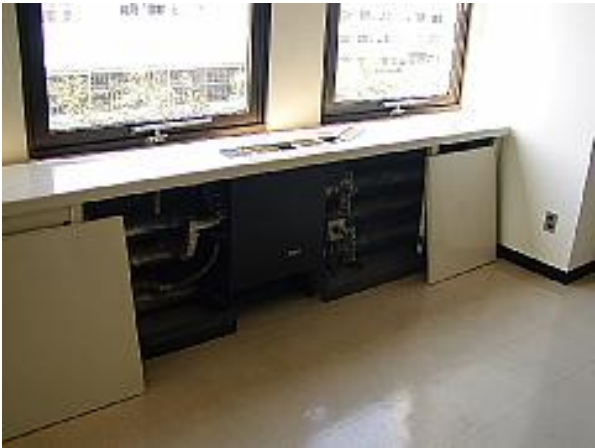
図 2.20 ペリメータカウンター内部の吹付けロックウール
