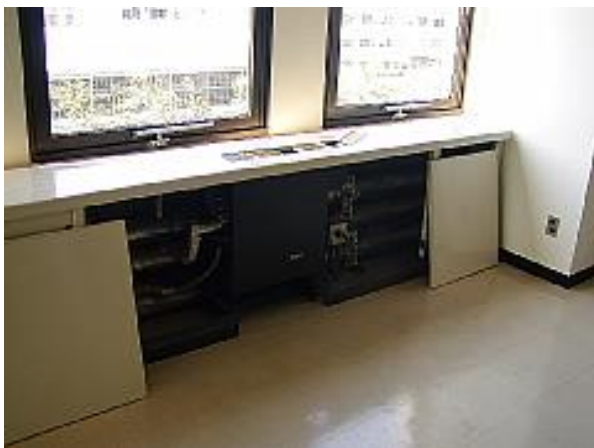
図 2.28 ペリメータカウンター内部の吹付けロックウール
