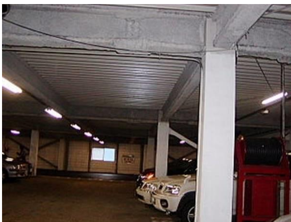
図 2.8 耐火被覆板と吹付けを併用する耐火構造
