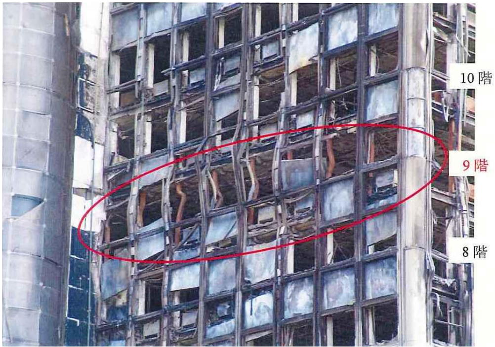
図 2.4 9階の耐火被覆の無いS造柱（撮影：宮本圭一）
