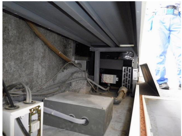
図 2.28 ペリメータカウンター内部の吹付けロックウール
