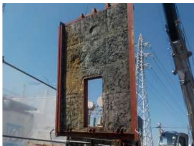
図 2.79 防音材（変電）
