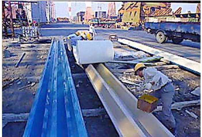
図 2.36 石綿フェルトを現場で貼り付けている状況
