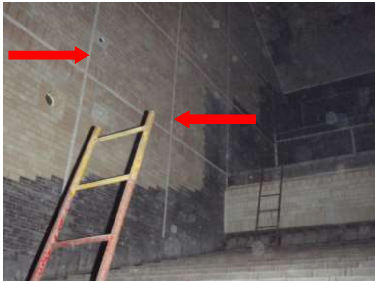
図 2.78 燃焼室の炉内側の耐火レンガと熱膨張しろエキスパンション（赤矢印の部分）
