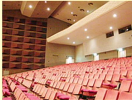
③ホール天井
