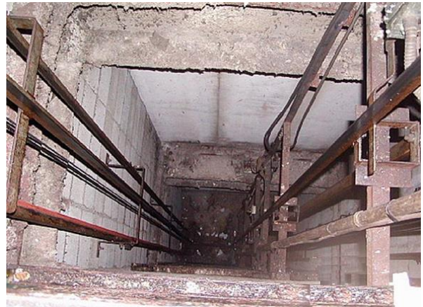
エレベーターシャフト
