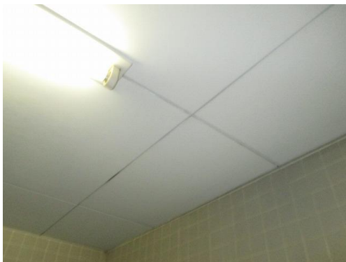
図 2.49 石綿含有パーライト板の施工例（左）と建材の近撮（右）
