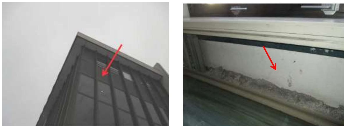
写真左：アルミカーテンウォール 写真右：板は、けい酸カルシウム板第1種2枚貼りと層間ふさぎ
