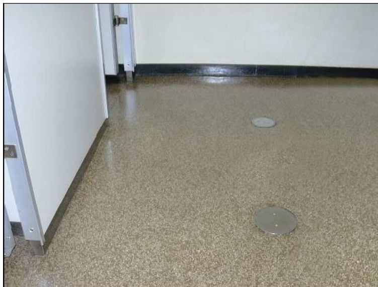
図 2.57 石綿含有ビニル床シートの施工例
