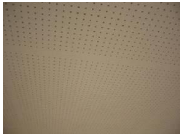
吸音用孔あき石綿セメント板
