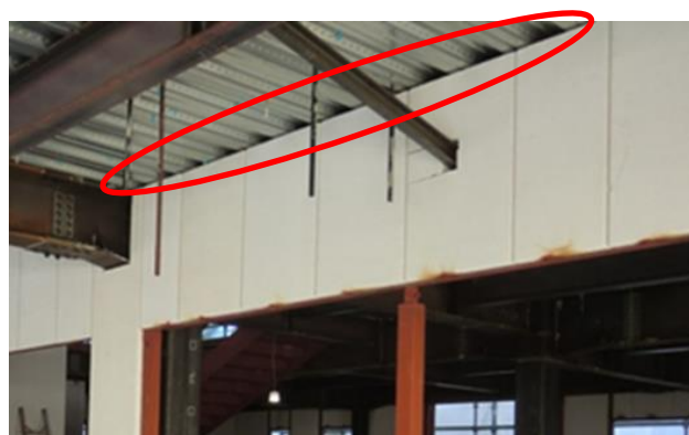
図 2.15 A L C壁施工風景（隙間塞ぎ前）
