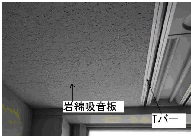
図 2.45 石綿含有ロックウール吸音天井板の施工例(2)
