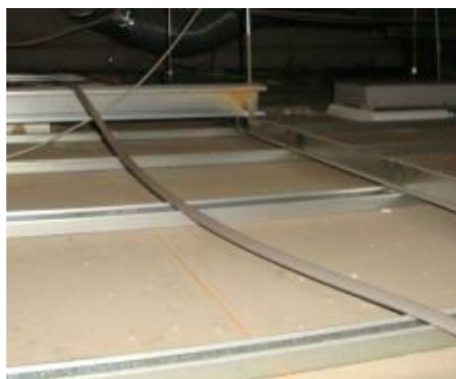
天井裏捨貼りの場合(表は岩綿吸音板) この捨貼りがせっこうボードである。
