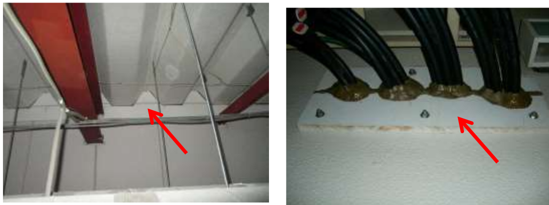
写真左：防火区画壁と屋根折板の取り合い部分の隙間ふさぎのけい酸カルシウム板第2種。 写真右：防火区画のケーブル貫通部のけい酸カルシウム板第2種。
