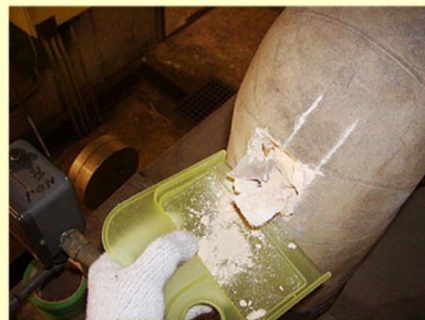
配管エルボ部分の石綿保温材 のサンプリング採取状況
