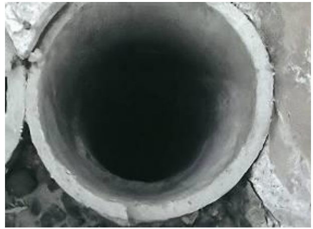
石綿セメント円筒（左写真の屋上）
