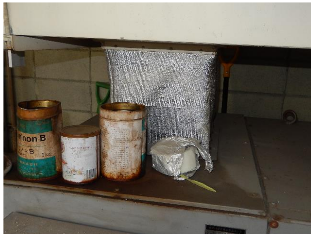
たわみ継手アルミ箔貼り（石綿布）
