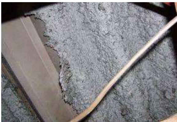
写真左：折板屋根の吹付け石綿の層状界面はく離 写真右：木毛セメント板（上）下地の浮いた吹付け石綿（下）の界面はく離
