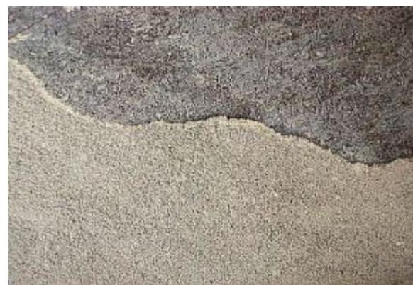
写真左：折板屋根の吹付け石綿の層状界面はく離
