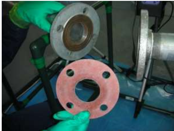
劣化していないガスケット
