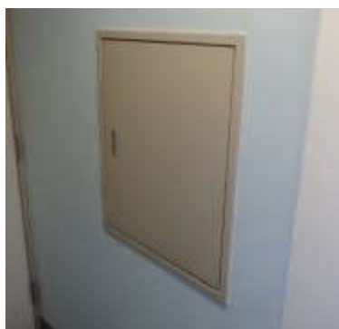
写真左：天井点検口 写真右：壁点検口
