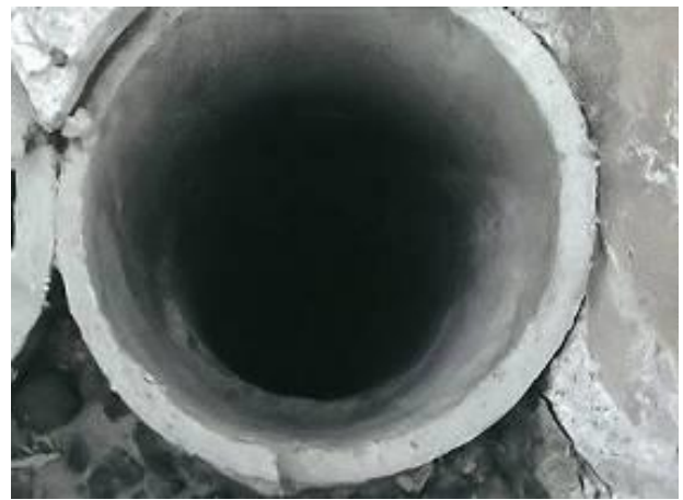
石綿セメント円筒（左写真の屋上）
