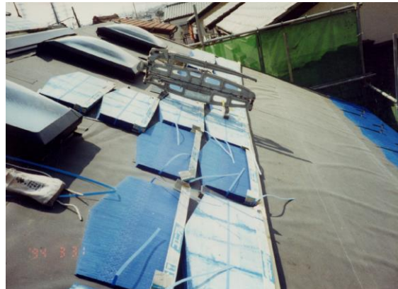
図 2.64 石綿含有ルーフィングの施工例
