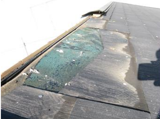
図 2.64 石綿含有ルーフィングの施工例
