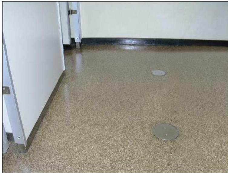
図 2.57 石綿含有ビニル床シートの施工例
