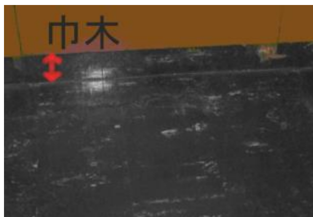
石綿含有ソフト巾木（ビニル床タイルと同材質の場合が多い）
