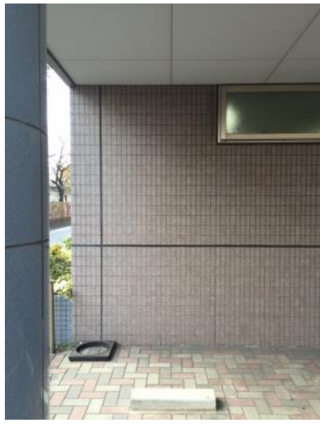
図 2.52 複合パネルの施工例
