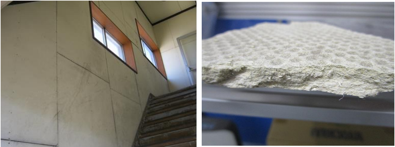
図 2.42 石綿含有パルプセメント板の施工例（左）と建材の近撮（右）
