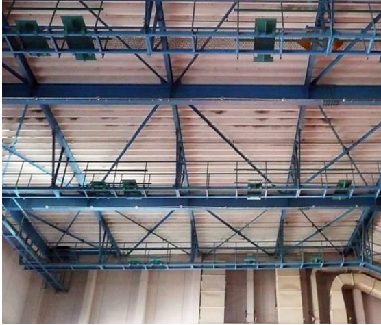
10 図 2.35 屋根用折板石綿断熱材施工例
