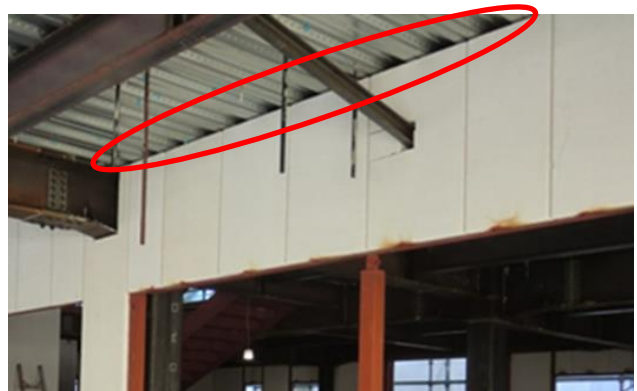
図 2.15 A L C壁施工風景 (隙間塞ぎ前)
