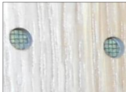
(拡大) 裏側にグラスウールを貼っている
