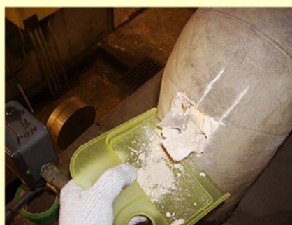
配管エルボ部分の石綿保温材 のサンプリング採取状況
