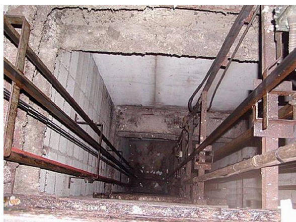
エレベーターシャフト
