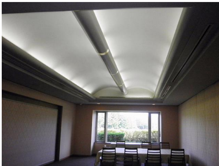
図 2.50 曲面ボードの施工例（玄関ホールや EV ホールに施工）
