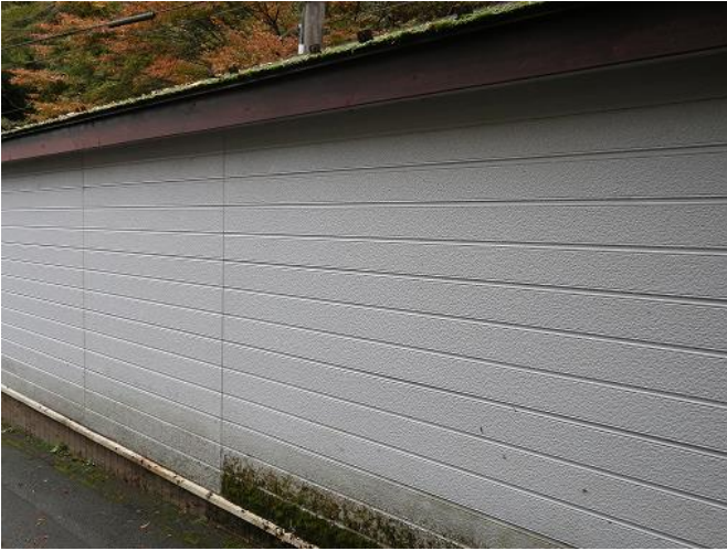
図 2.60 石綿含有建材複合金属系サイディングの施工例
