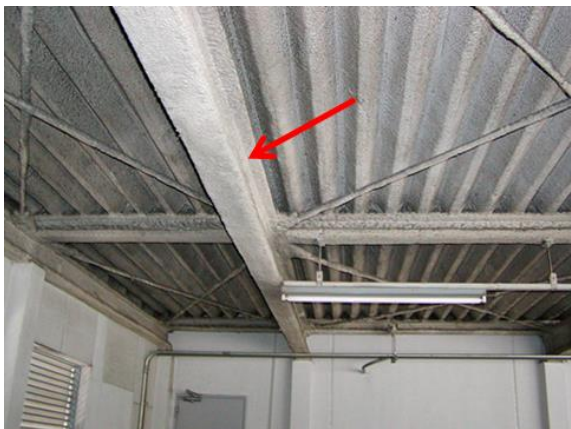
図 2.6 鉄骨はりの吹付け耐火被覆
