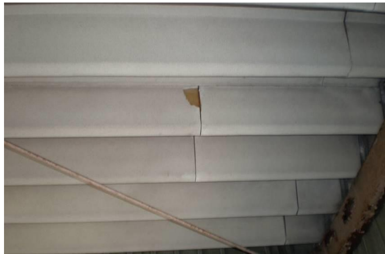
図 2.37 石綿含有炭酸カルシウム発泡断熱材
