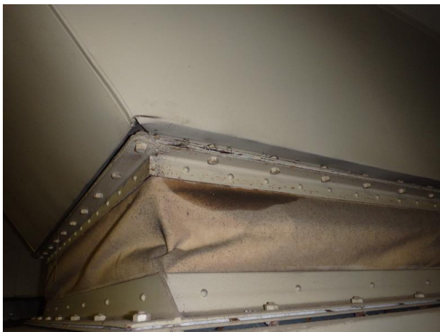
ダクト用ガスケットと継手（石綿布）
