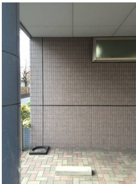
図 2.30 複合パネルの施工例
