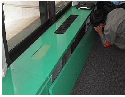
柱きわなどのファンコイルカバ ーを外しCW裏や層間を見る
