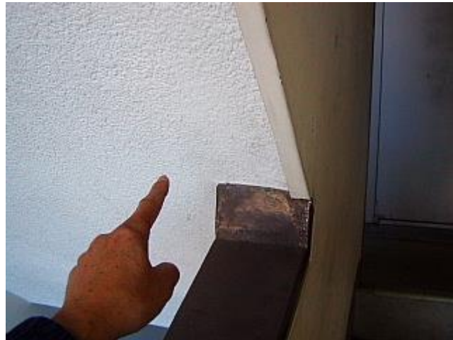
階段 吹付けバーミキュライトに複数回の塗装仕上げ（見間違いしやすい）
