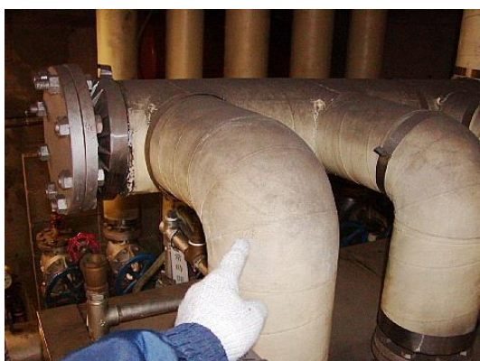
⑪ 1号ボイラー・配管エルボ(第1節目) けいそう土保温材採取位置
