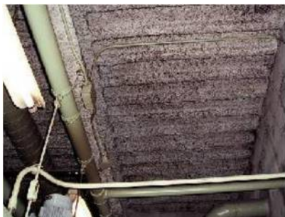
天井断熱材、天井、壁吸音材
