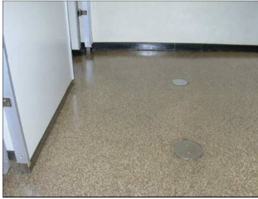
ビニル床シート（裏面に印字がない場合が多い）
