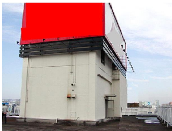
屋上。写真右側が東、手前が南。煙突は広告塔の内部にありPH2EV機械室の奥のドアからタラップを上り、天蓋を開けて出入りする。
