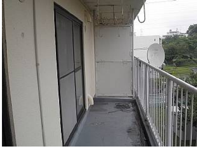
戸境壁の石綿セメント板。火災時などはこれを破って隣家に逃げる。
