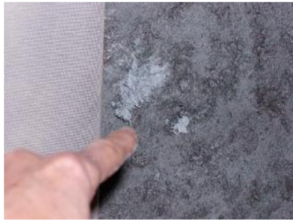
商業ビル機械室 左のガラスクロス下の 吹付け石綿
