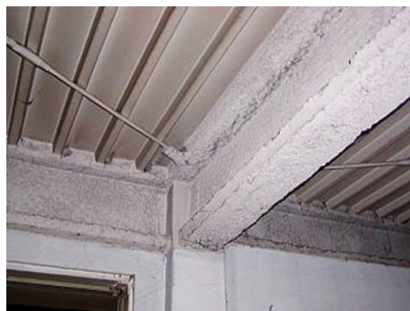
図 2.70 耐火被覆板と吹付けを併用する耐火構造
