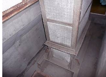
煙突断熱材「角型ハイスタック」 アングル固定型タイプ
