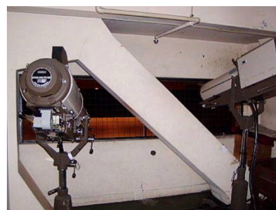
調光室など。筋交い（ブレース）に耐火被覆板が使用されている
