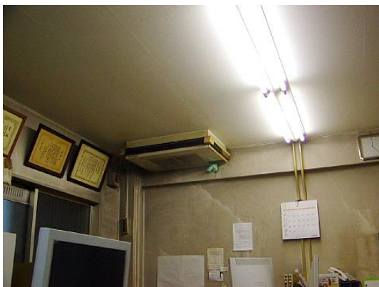
A 事務室 ボードの天井裏はRC打ち放し。
