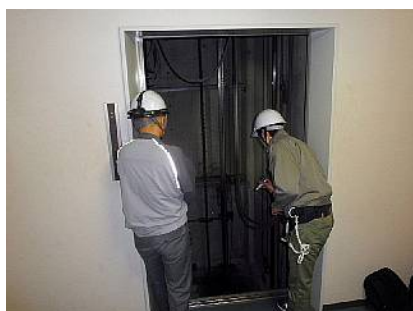
E Vシャフト内の採取は保守会社の立会いが必要となる
