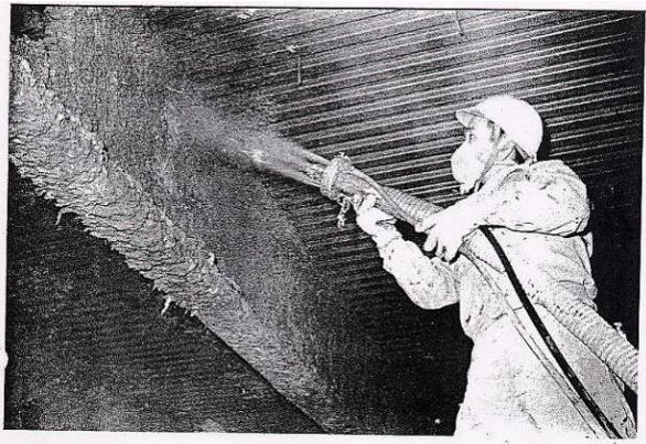
図 2.7 乾式吹付け施工と機械
