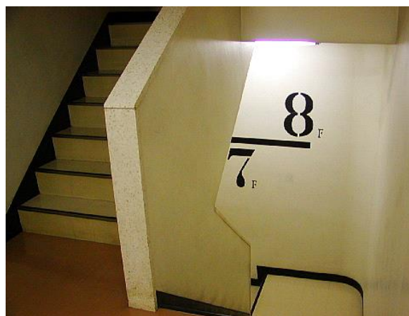
壁はモルタルに塗装、階段床面(踏み面)はPタイル(不採取)
