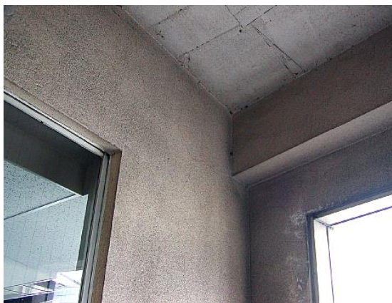
8F パッケージ室(壁リシン、天井RCのため不採取)
