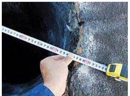
⑨トップ状況・内径などの計測
