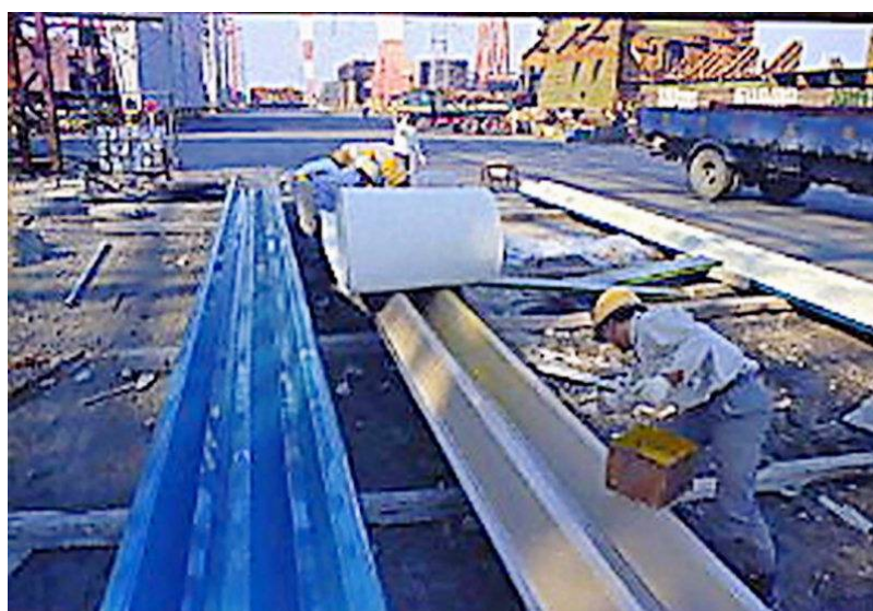
図 2.16 石綿フェルトを現場で貼り付けている状況
