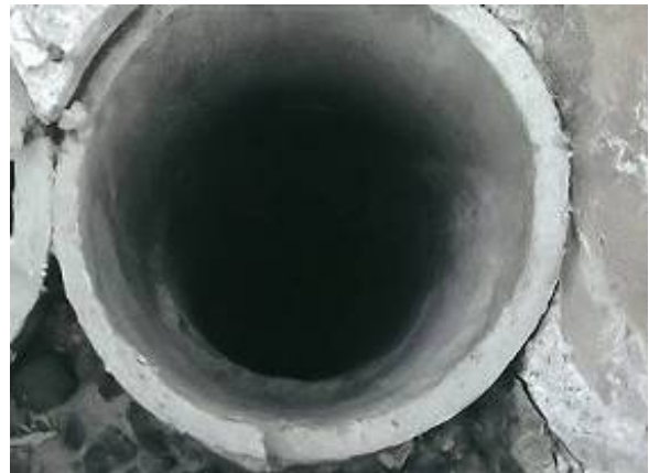
石綿セメント円筒（左写真の屋上）
