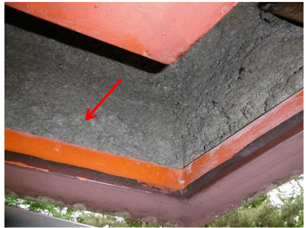
写真右: 庇内部に施工された吹付け材
