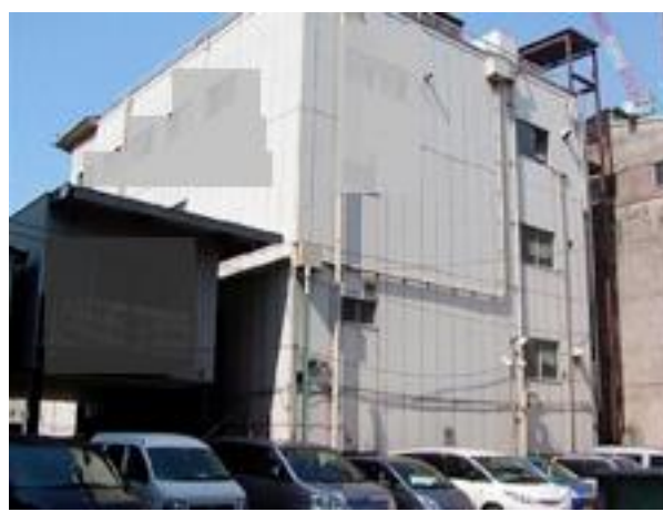
裏側 店舗がS造で事務所はRC造、 2棟が連結された複雑な建築物
