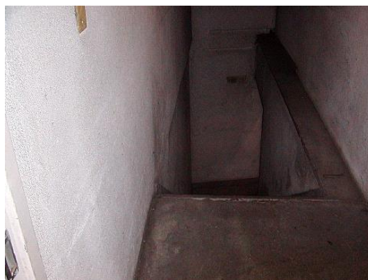
㉒ B1F D階段 天井・壁はRC打放しで吹付け材はなし
