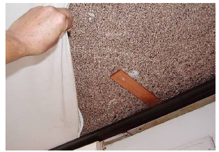
幕天井工法（左側）によるバーミキュライト落下防止措置例
