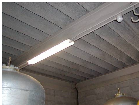
図 2.73 不燃材料の吹付けロックウールの使用箇所例 （折板屋根の裏面の石綿含有ロックウール）
