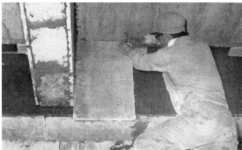
図 2.10 石綿耐火被覆板施工状況
