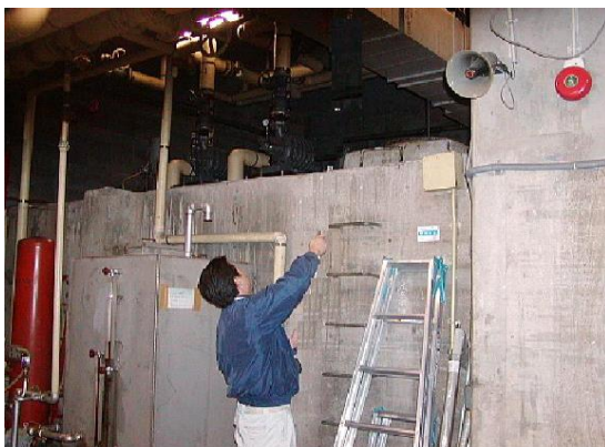
③ 機械室A。はりを除く天井部分に吹付け材あり。採取位置などの検討
