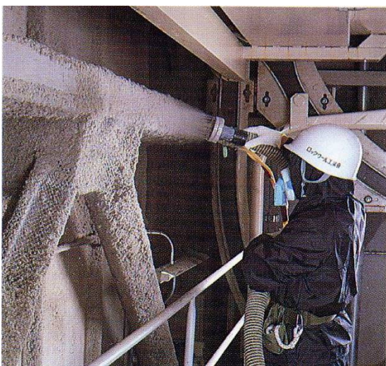
図 2.8 半乾式吹付け施工と機械
