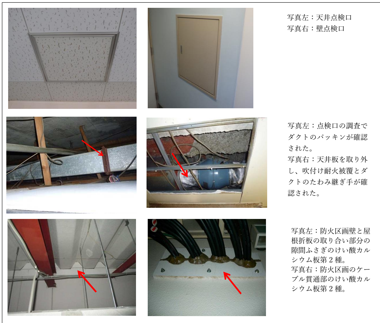
図 3.11 隠ぺい部の調査
