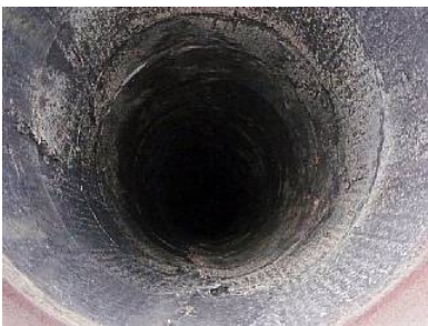
煙突断熱材「カポスタック」頂 部から撮影
