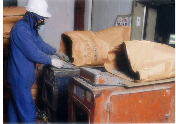
図 2.7 乾式吹付け施工と機械
