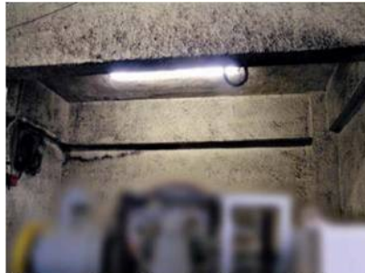
機械室吸音材
