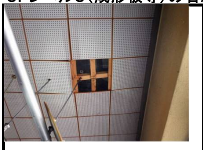
a)木質系吸音板 (吸音テックス)
