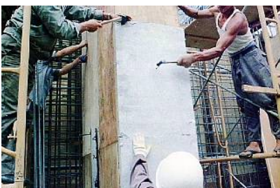
煙突断熱材「角型カポスタック」 施工中。コンクリート打込みタイプ
