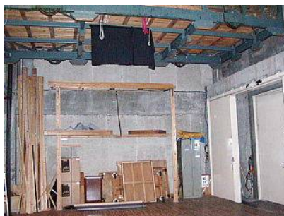
舞台横には大道具室があり何らかの吸音対策が施されている
