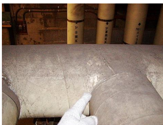
⑭ 2号ボイラー 第3節T字部分(採取位置の確認)
