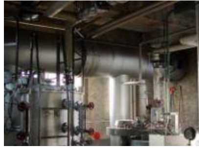
②ボイラー室雰囲気撮影
