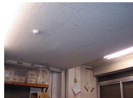
D 車路下事務室(旧・倉庫)。ボードの天井裏はRC打ち放し。
