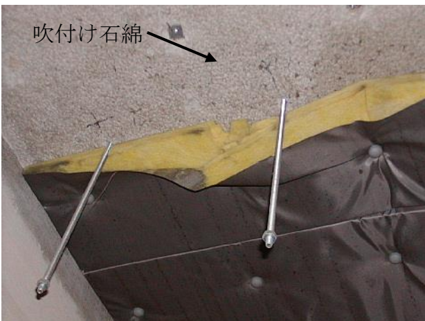
製本・印刷工場感光室天井。吹付け石綿の上にグラスウール+黒寒冷紗張仕上げ
