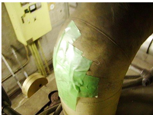
⑬ 採取箇所への復旧(テーピング)
