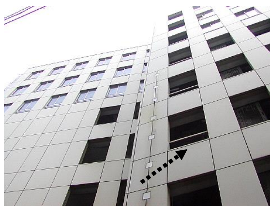
北側の道路から見上げた位置
