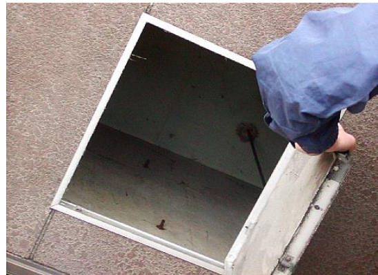
同左。軒天井裏に断熱材はナシ。軒天井板は石綿セメント板下地、ボンタイル調の塗装(不採取)。
