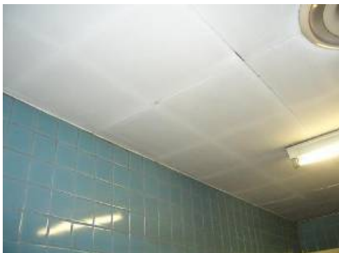
軟質フレキシブル板（釘打ち止めの状況）
