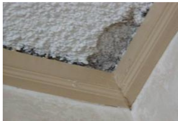
居室 吹付け石綿の上から石綿対策工事として吹付けパーライト
