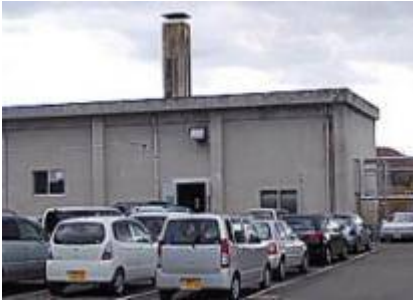
①建屋全景・煙突望遠
