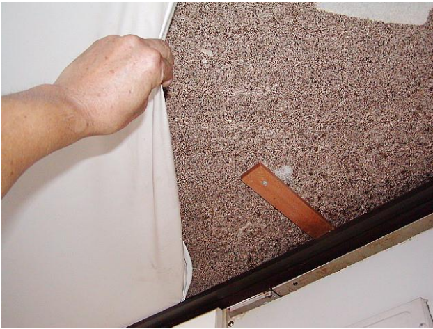
共同住宅の居間天井（バーミキュライト）。ビニール被膜による覆い
