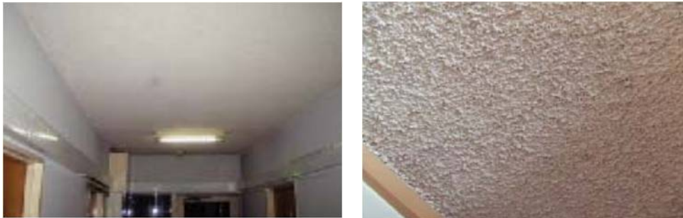
天井仕上げ材
