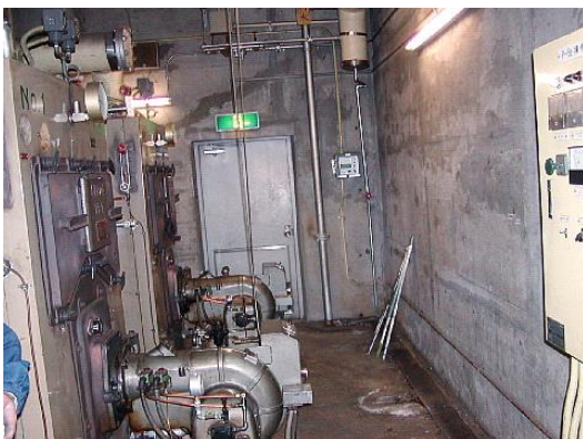
ボイラー室雰囲気。正面ドアの幅850mm。壁はRC打放し、天井は吹付けあり
