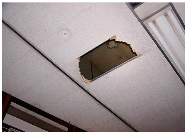
同左 天井開放(北側)。断熱材は無し。
