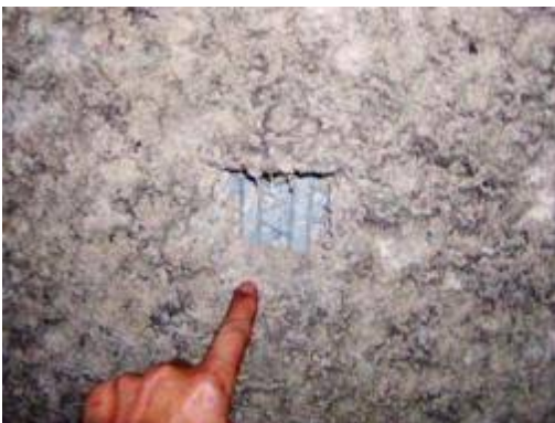
リプラス下地の吹付けRW、写真掲載ページに余裕があれば、組写真とした方がよい場合もある 階段室の防火区画で左壁のブロック上にラス網
