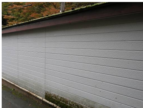
壁（裏打材に石綿含有成形板を使用）
