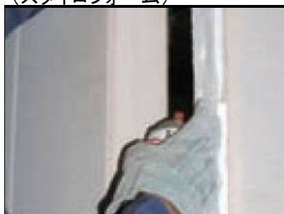
d)耐熱性セラミックス繊維の目地材 RCF(リフラクトリーセラミックスファイバー)
