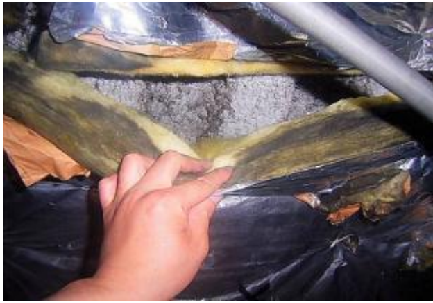
商業ビル グラスウール断熱材の裏の吹付けRW
