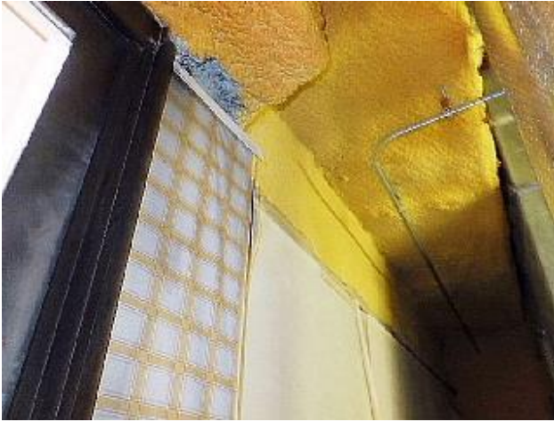
石綿含有吹付けロックウールの上にウレタンを吹付け
