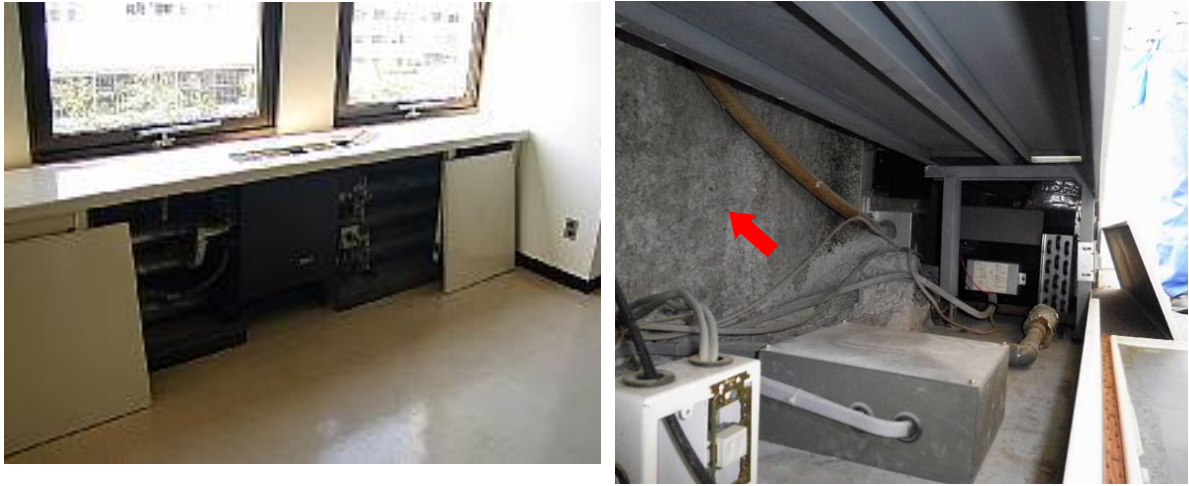
図 2.102 ペリメータカウンター内部の吹付け
