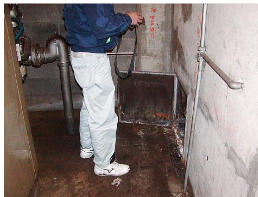
点検口開放。ボイラーのRC架台あるため幅は800mm。点検口(500角)
