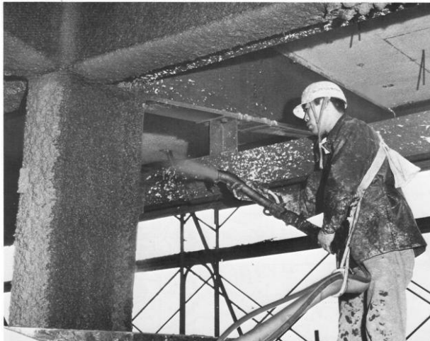
図 2.9 湿式吹付け施工と機械
