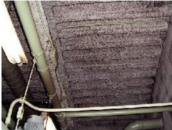
天井断熱材 天井、壁吸音材
