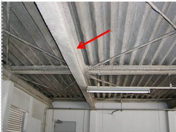
図 2.68 鉄骨はりの吹付け耐火被覆
