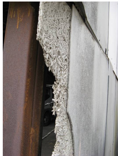
図 2.29 複合ボードの施工例
