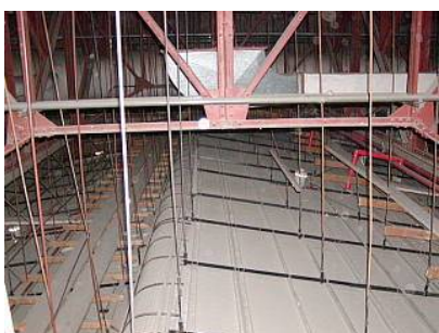
客席の天井裏。左に歩廊、トラス状の大梁には吹付け石綿などあり
