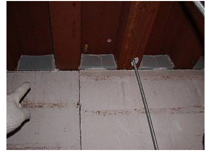
ケイ酸カルシウム板二種によるは りの耐火被覆および同材によるデ ッキプレートとの間の小間詰め
