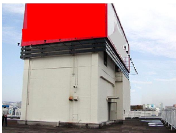
屋上。写真右側が東、手前が南。煙突は広告塔の内部にありPH2EV機械室の奥のドアからタラップを上り、天蓋を開けて出入りする。
