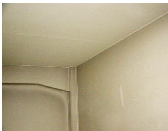
天井見上げ撮影。ボード下地に塗装。天井裏はCH5,000で見られず(図面では断熱材は未記載)
