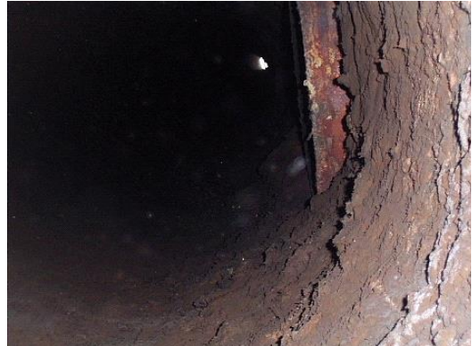
煙突内部撮影。右は横引き煙道の導入部。その上に煙突トップを確認
