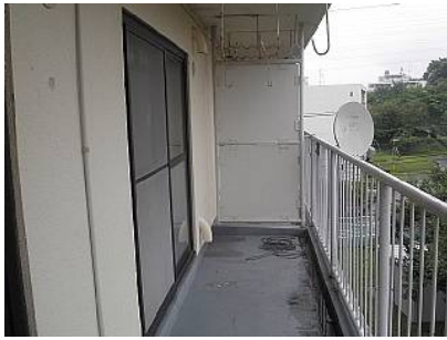
戸境壁の石綿セメント板。火災時などはこれを破って隣家に逃げる。
