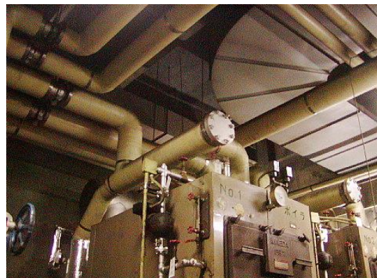
② ボイラー室。天井に吹付けRW(乾式・半乾式)の確認(CH=5,100)
