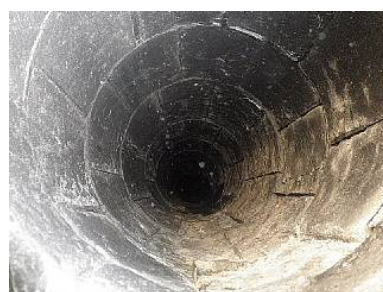
煙突断熱材「パールスタック」頂部から撮影
