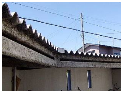
駐輪場、物置などの屋根（折板、波型スレート）や部材にも留意しておく
