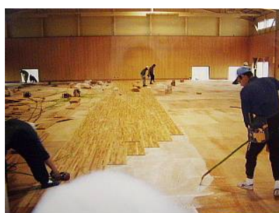
体育館の床は鋼製の根太が組まれた下地になっている。この上に複層の仕上げをする。
