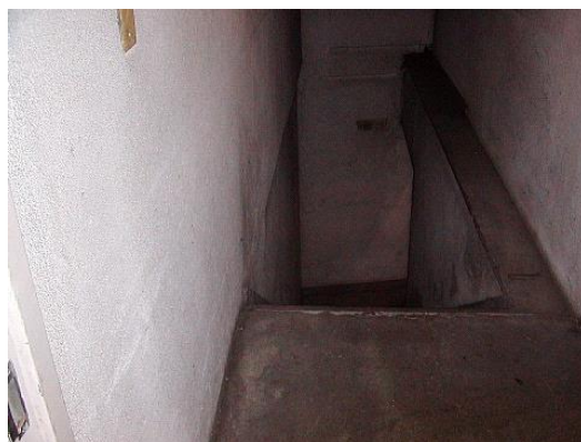
⑯ B1F D階段 天井・壁はRC打放しで吹付け材はなし
