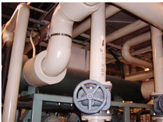
配管保温材ほか(保温材、バルブパッキンほか)不採取
