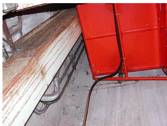
C 小型昇降機シャフト内部。RC打ち放し。
