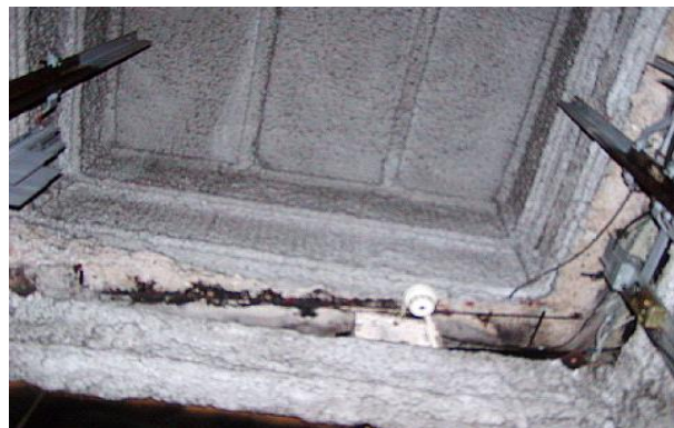
EVシャフト内。見上げ撮影(はり、柱、天井)。EVはリフトアップ方式(上部からの巻上げ方式ではない)。
