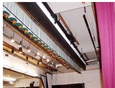
舞台緞帳の上のブドウ棚にも吸音対策が施されている
