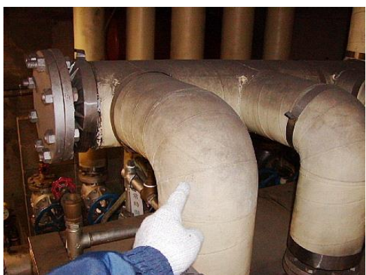
⑪ 1号ボイラー・配管エルボ(第1節目) けいそう土保温材採取位置
