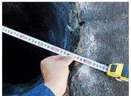
⑨トップ状況・内径などの計測
