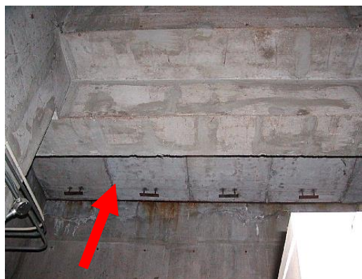
⑫ B1F マシンハッチ(見上げ撮影)。吹付け材はなし。機械室Aとは区画されていない。
