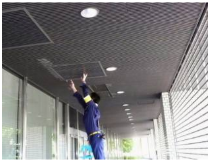
ピロティー形式の天井裏などを 見る
