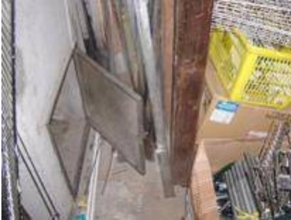
④点検口前の片付け
