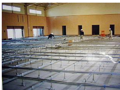
体育館の床は鋼製の根太が組まれた下地になっている。この上に複層の仕上げをする。
