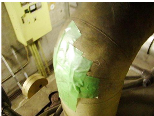
⑬ 採取箇所への仮復旧(テーピング)
