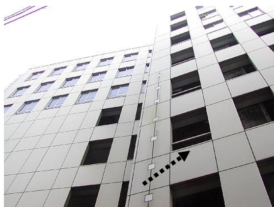
北側の道路から見上げた位置
