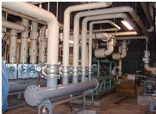
① 機械室A はりを除く天井部分に吹付けRW(乾式・半乾式)あり。
