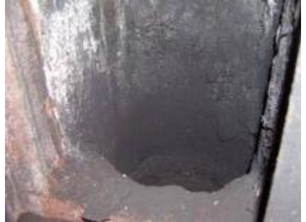
⑥点検口より底部を見る
