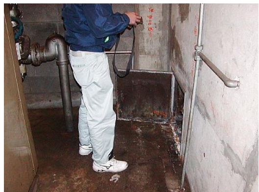
点検口開放。ボイラーのRC架台があるため幅は800mm。点検口(500角)
