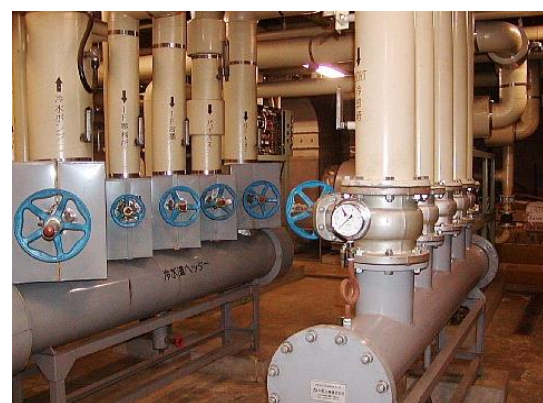
④ 同左、バルブ部ラッキング保温材(不採取)
