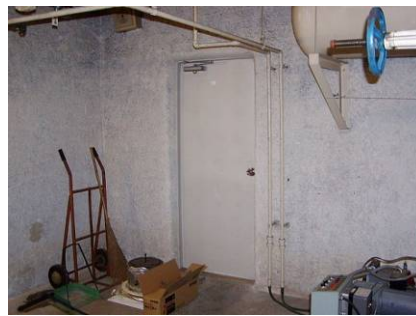
2面（壁＋壁、壁＋天井など）
