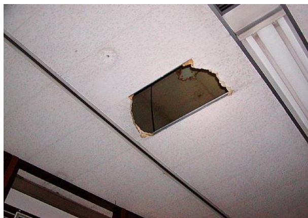
同左 天井開放(北側)。断熱材は無し。
