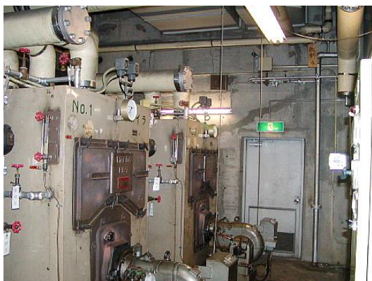
⑨ ボイラー室、吹付けRW(乾式・半乾式)確認
