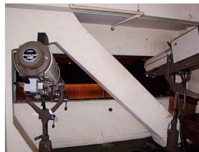
調光室など。筋交い（ブレース）に耐火被覆板が使用されている
