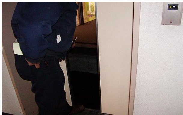
南側シースルーEV。シャフト内部を開放し(EV業者立会いによる)目視および採取。
