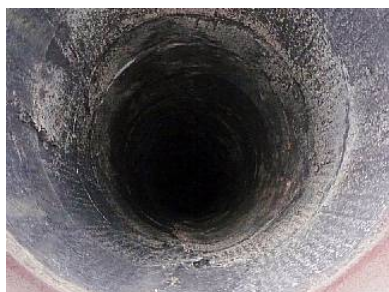
煙突断熱材「カポスタック」頂部から撮影
