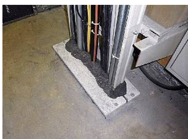
ケーブル貫通口。上下階や隣室などの開口部には耐火パテ、ケイ酸カルシウム板2種などの耐火板が使用される
