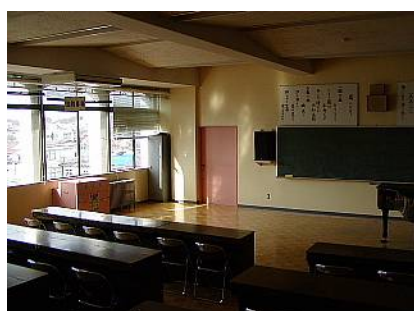
音楽室、放送室の壁、天井は音響効果を高める仕上げ材がある。その裏側にも注意したい。
