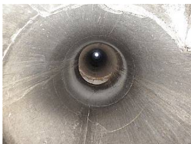
煙突断熱材「ハイスタック」点検口から撮影
