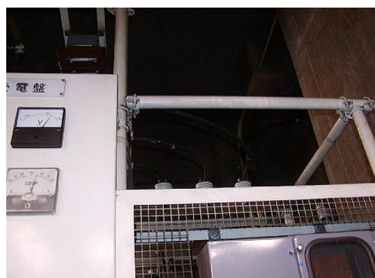
⑧ 同左、天井・吹付けRW(乾式・半乾式)の目視確認(はりを除く天井部分)
