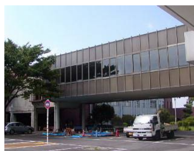
離れた建物への移動に渡り廊下がある。開口部がなく調査が困難な場合もある。
