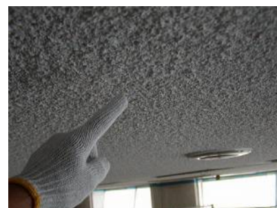
可能な限り対象面に近づいて観察したい。採取の場合は下地材まで取らないように注意する。
