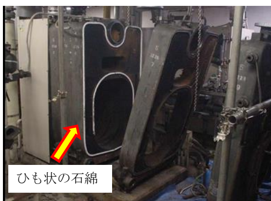
各セクションのジョイント部にはひも状の石綿が使用されている。
