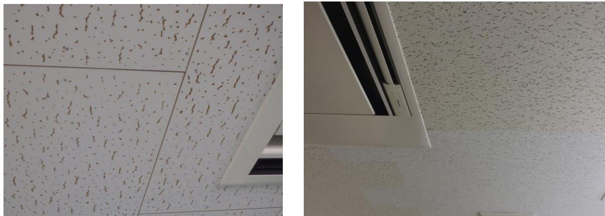
写真左：化粧せっこうボード（通称として使用される商品名：ジプトーン）の施工例。軽天にビス止めしており、継ぎ目が見える。
