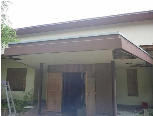
写真左: 庇の調査
