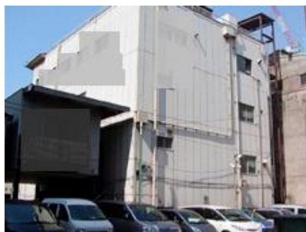
裏側 店舗がS造で事務所はRC造、 2棟が連結された複雑な建築物
