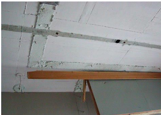
改修が繰り返された部屋。前の間仕切り壁の上部に吹付け石綿が取り残されている。
