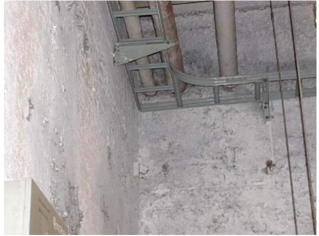
石綿封じ込め工事。表層は塗装仕上げに見える
