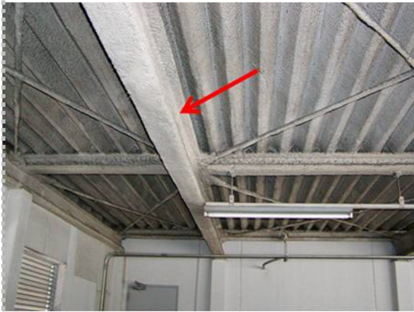
図 2.68 鉄骨はりの吹付け耐火被覆
