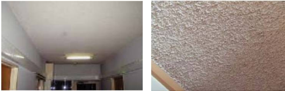
天井仕上げ材
