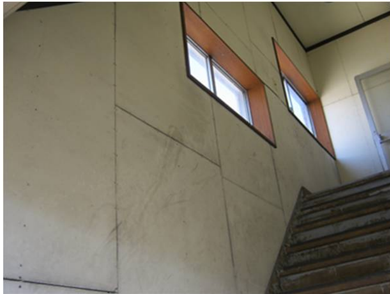
図 2.21 石綿含有パルプセメント板の施工例
