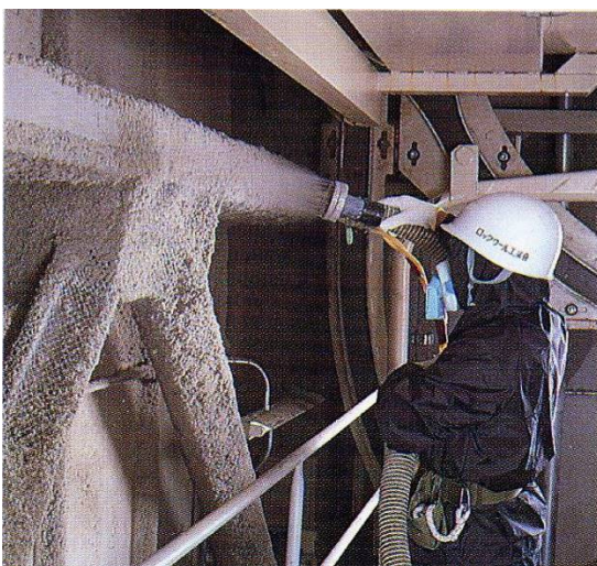
図 2.8 半乾式吹付け施工と機械
