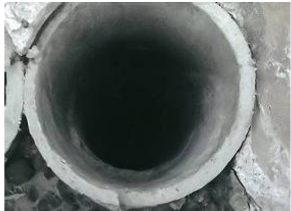
石綿セメント円筒（左写真の屋上）
