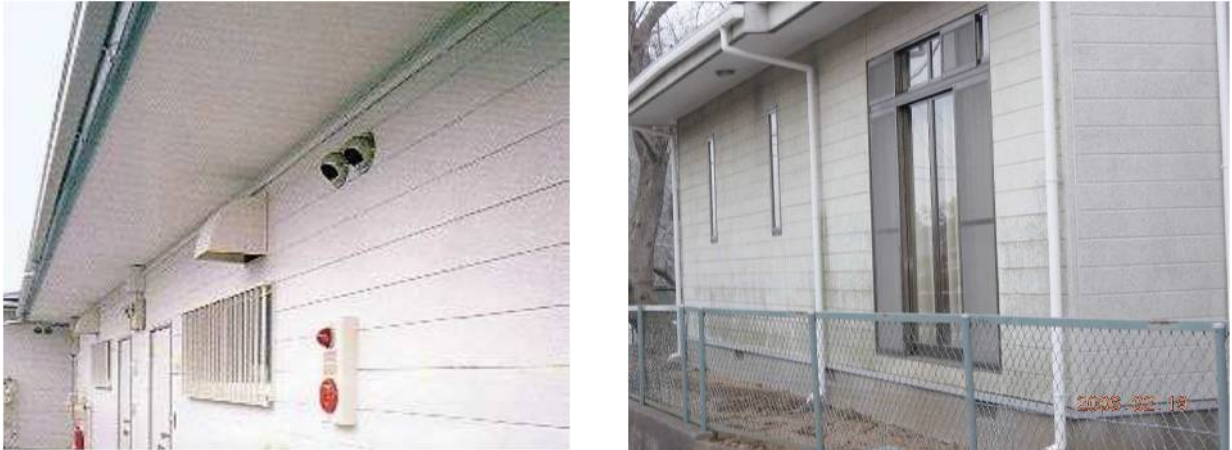
図2.37 石綿含有窯業系サイディングの施工例
