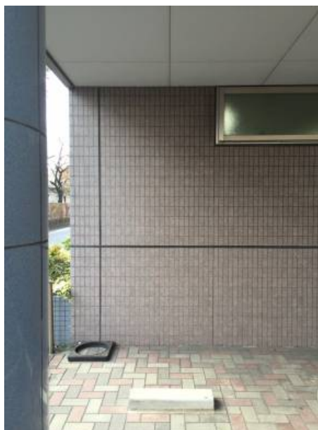
図 2.30 複合パネルの施工例
