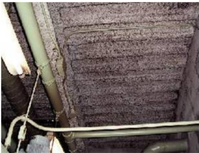
天井断熱材、天井、壁吸音材
