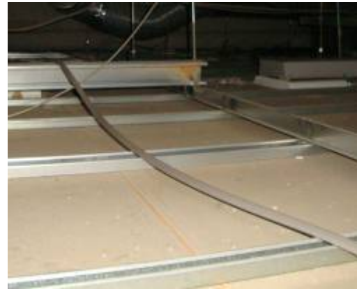
天井裏捨張の場合（表は岩綿吸音板） この捨張が積層板である。
