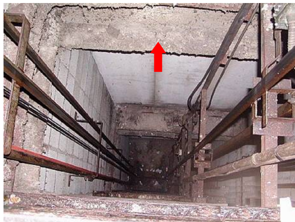
図 2.104 小荷物専用昇降機シャフト内の吹付け
