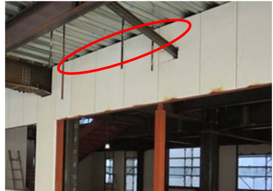
図 2.79 A L C壁施工風景（隙間塞ぎ前）
