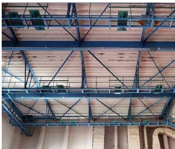
図 2.15 屋根用折板石綿断熱材施工例
