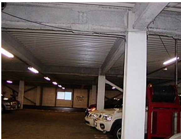
図 2.70 耐火被覆板と吹付けを併用する耐火構造
