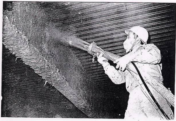
図 2.7 乾式吹付け施工と機械
