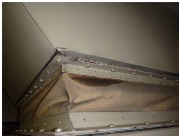
ダクト用ガスケットと継ぎ手（石綿布）
