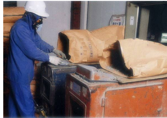
図 2.7 乾式吹付け施工と機械
